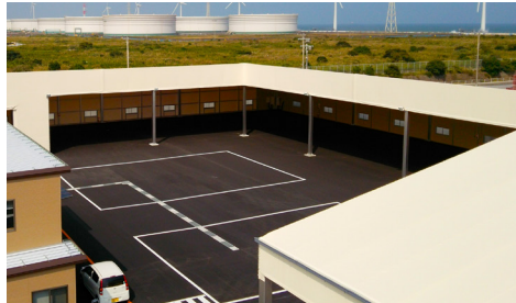
施工例：工場荷捌き場
