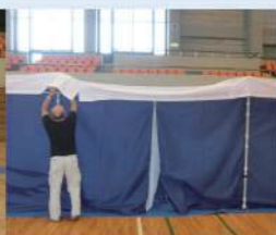
2棟設置後、補強パイプを連結します
