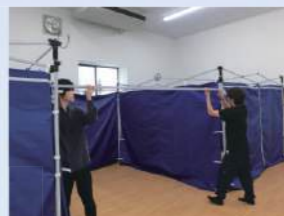
2棟設置後、補強パイプを連結します
