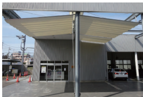
作業スペースをより快適に
