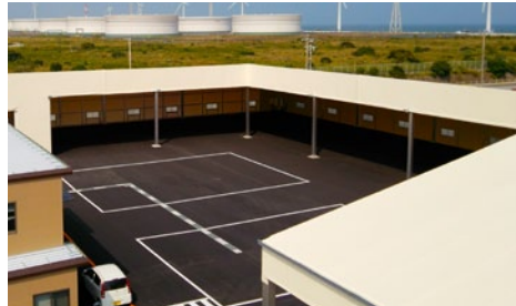
施工例：工場荷捌き場
